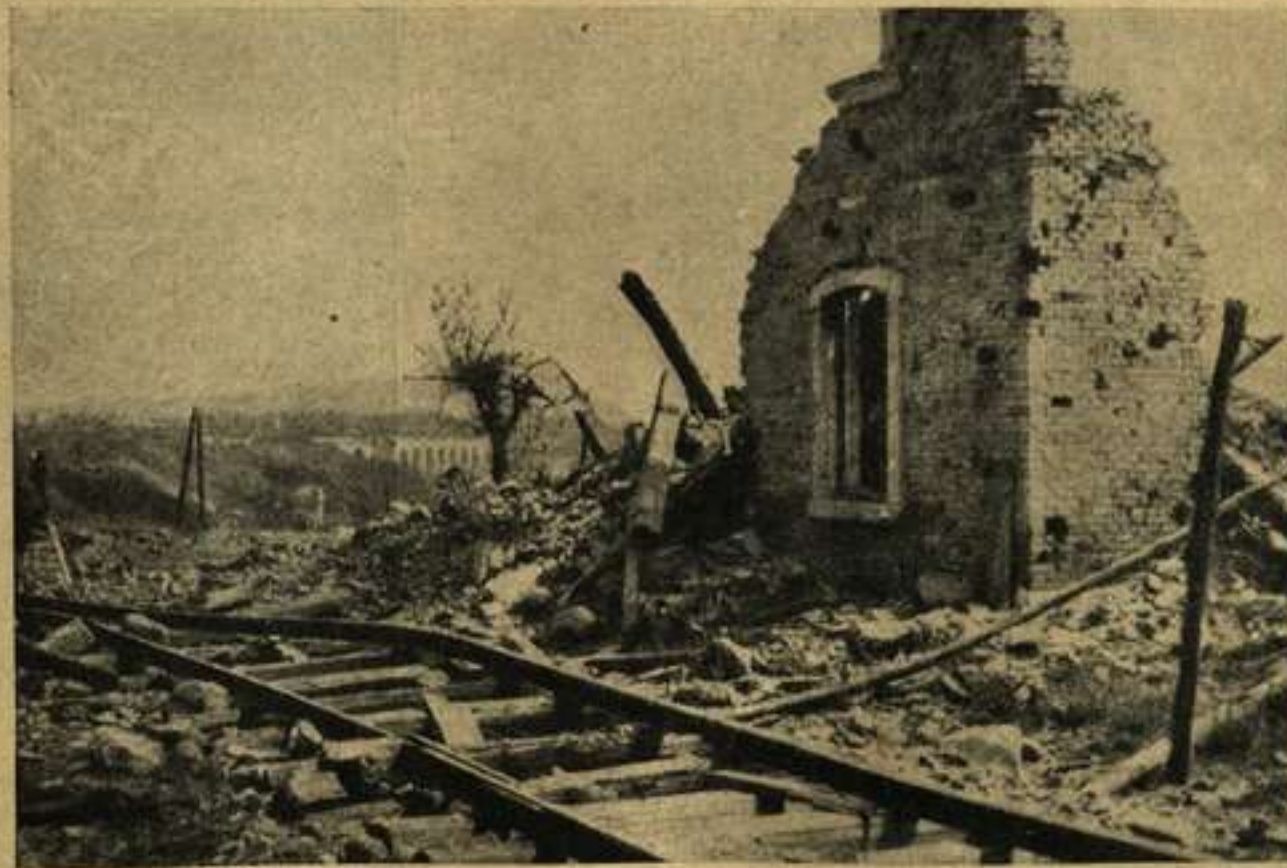
Разрушенная снарядами желѣзная дорога между Лучинико и Горичей.
