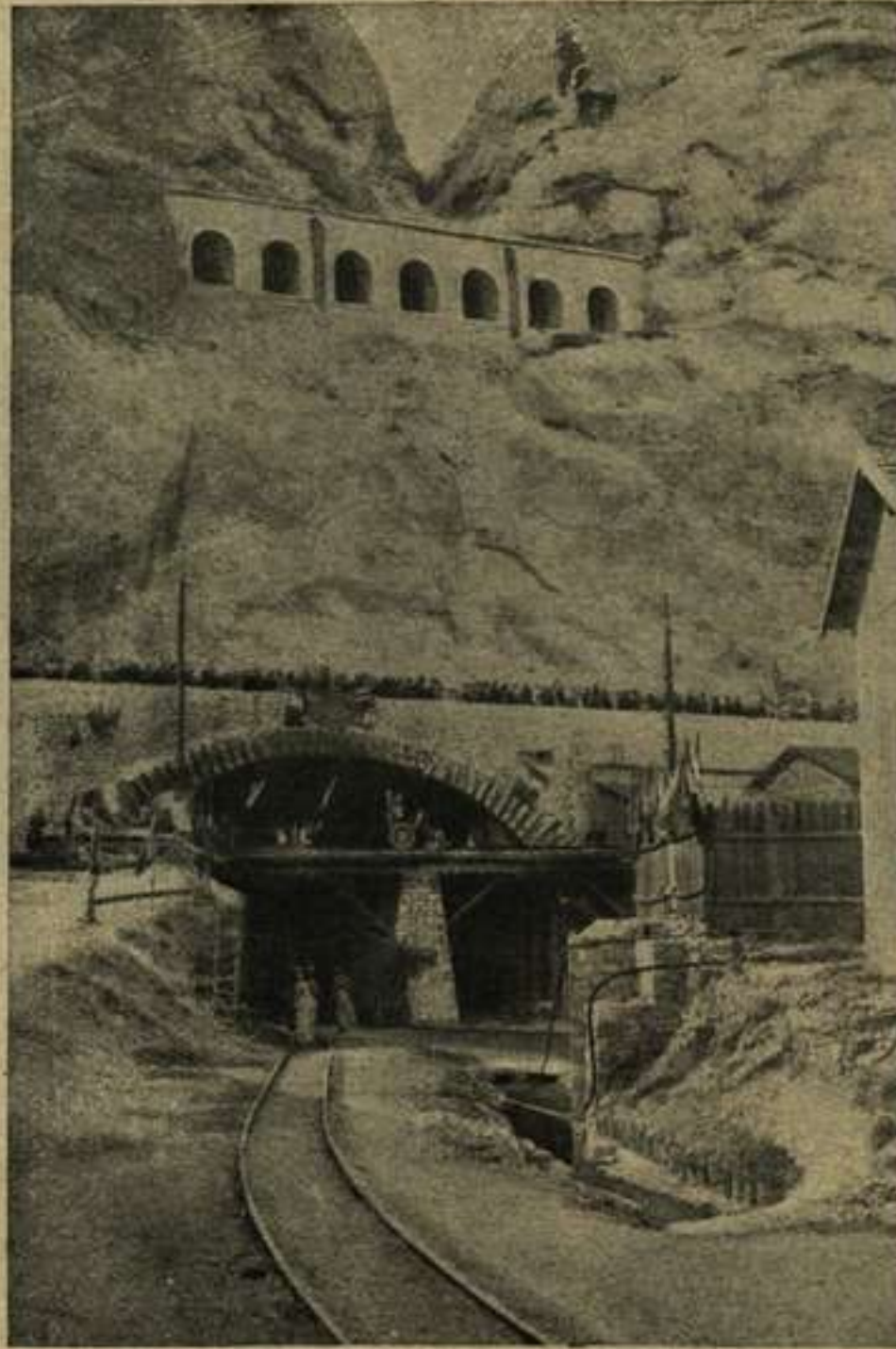
Во Франціи только что закончилась первая часть соорудимаго огромнаго канала отъ Марсели къ рѣкѣ Ронъ. Каналъ имѣетъ около 75 верстъ въ длину. Подземная часть его проходитъ на 7 верстъ, имѣя въ ширину 72 фута и въ глубину 16 футовъ. Вышина ея отъ поверхности воды до свода—36 фут. Сооруженіе канала обошлось въ 36 мил. руб., а тунель стоилъ 21.200.000 руб.
