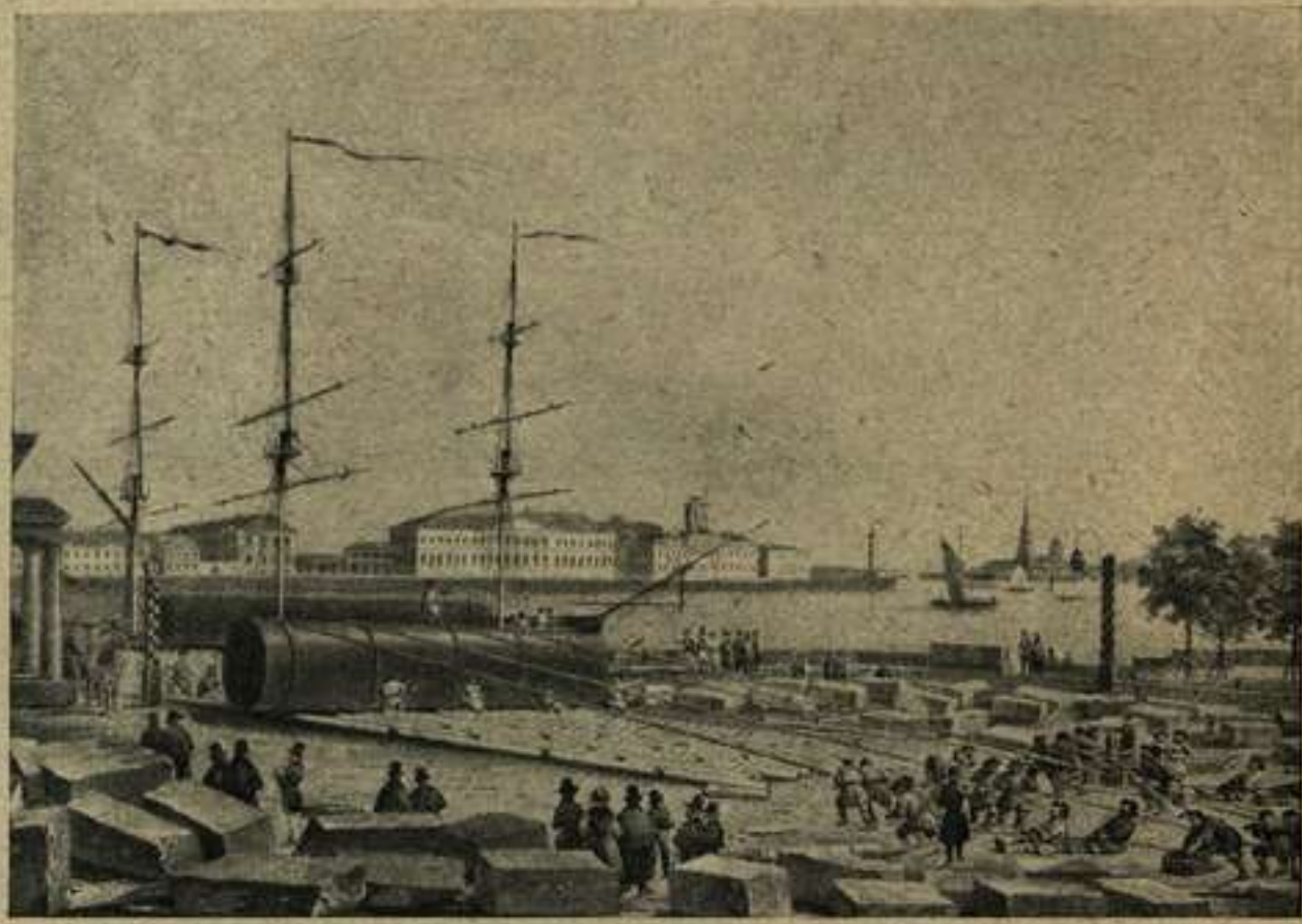
Пристань на Невѣ вблизи Адмиралтейства, гдѣ выгружались привезенныя изъ Финляндіи колонны для Исаакіевскаго собора. Здѣсь по бревнамъ онѣ снатывались въ особое помѣщеніе, гдѣ уже отдѣлывались окончательно.
