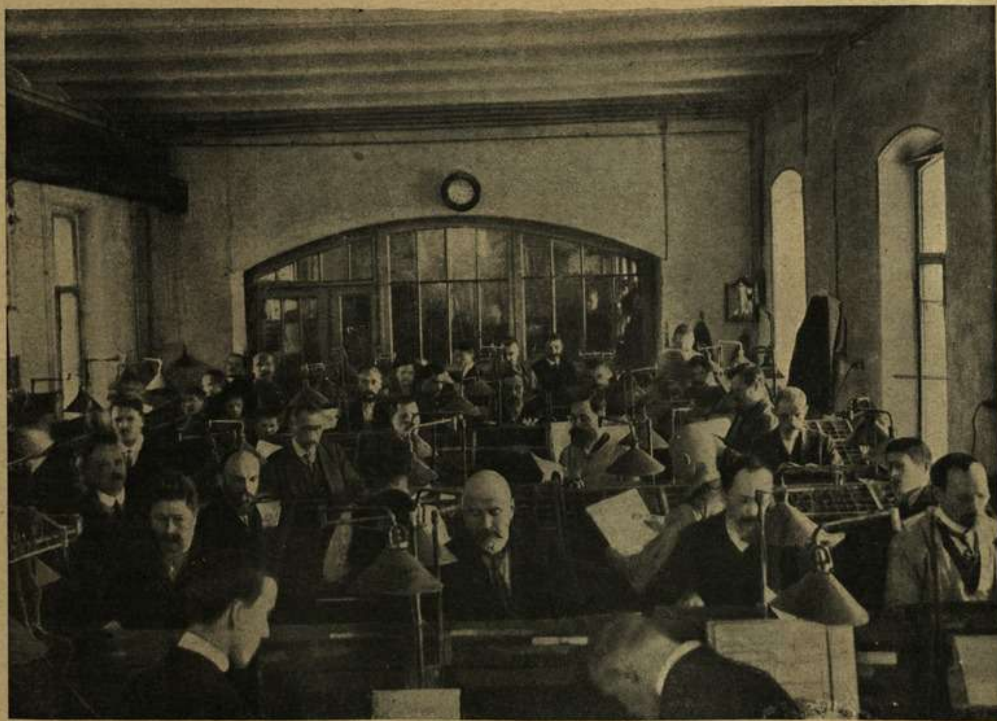
Часть большой газетной наборной въ типографіи «Новаго Времени». — Ручное отдѣленіе.
