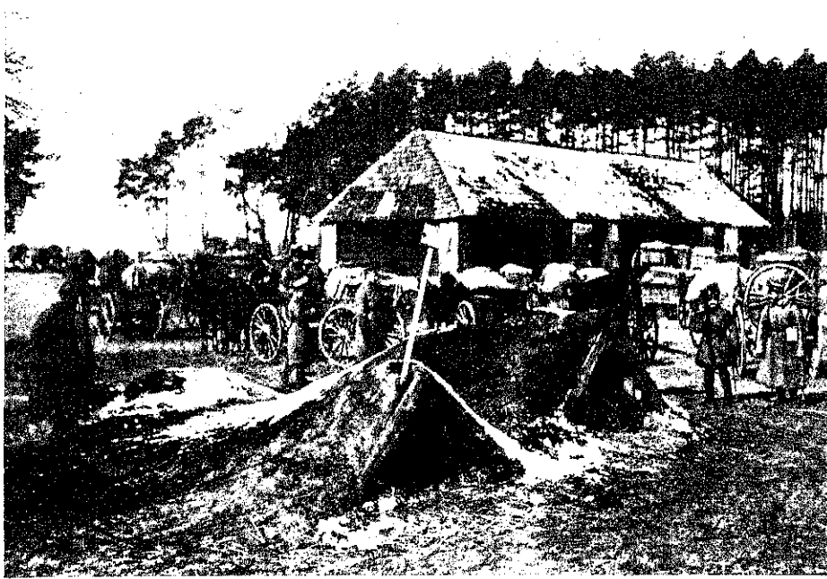
На позиціях. Батарейные резервы.
