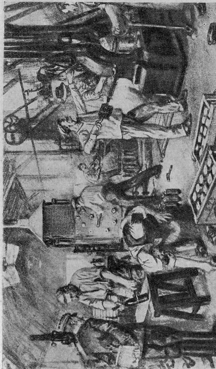
Небольшая частная фабрика въ одной изъ французскихъ провинци. Изготавливающая снаряды для орудій крупнаго калибра. Слева — инженеръ, посѣщающій фабрику въ качествѣ военнаго инспектора, слѣдящаго ежедневно за правильнымъ изготовленіемъ снарядовъ.
